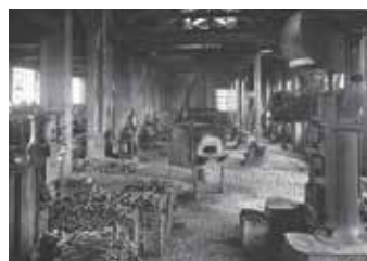
1939 Sectia de forjare
